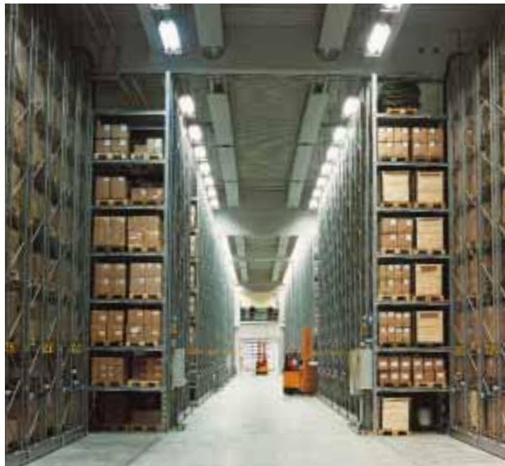
MOVO er mobile pallereoler som kan spare op til 80% gulvplads sammenlignet med stationære pallereoler. Yderligere en mulighed med Silverline P90.
