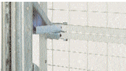
Ved at anvende hængende bøjleledere kan du opdele bærelagene i mindre rum.
