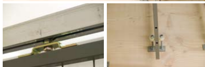
Øverst ses magasinet med ArteStore gittervægge der er her er monteret på udtræksrammer. Nederst til venstre ses, hvordan udtræksrammen er fastgjort med beslag i toppen, og til højre ses fastgørelsen i gulvet.
